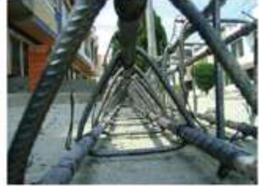
Después de habilitar el acero (cortes y dobleces), es necesario armar (unir) cada barra o elemento, con amarres de alambre recocido, tal y como se especifica en el proyecto estructural.
