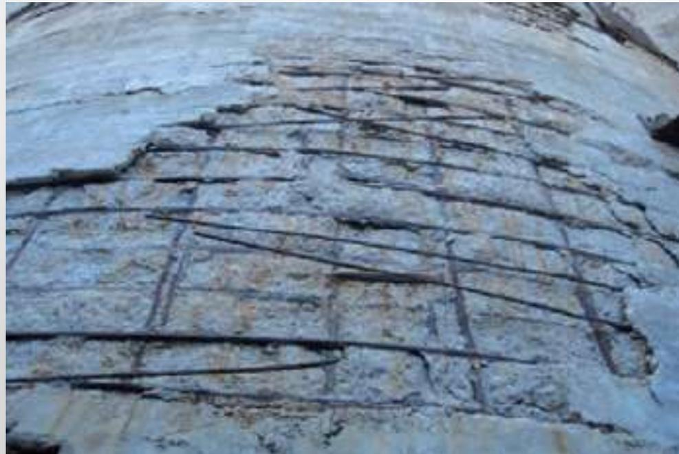
En cualquiera de los casos el recubrimiento mínimo debe ser de 1.5 veces el tamaño máximo del agregado (TMA) utilizado.
