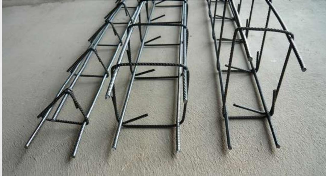
Están formados por dos o tres, o cuatro alambres longitudinales corrugados calibre 14 y por alambres transversales corrugados con las mismas características que los longitudinales, espaciados a cada 25 cm.
