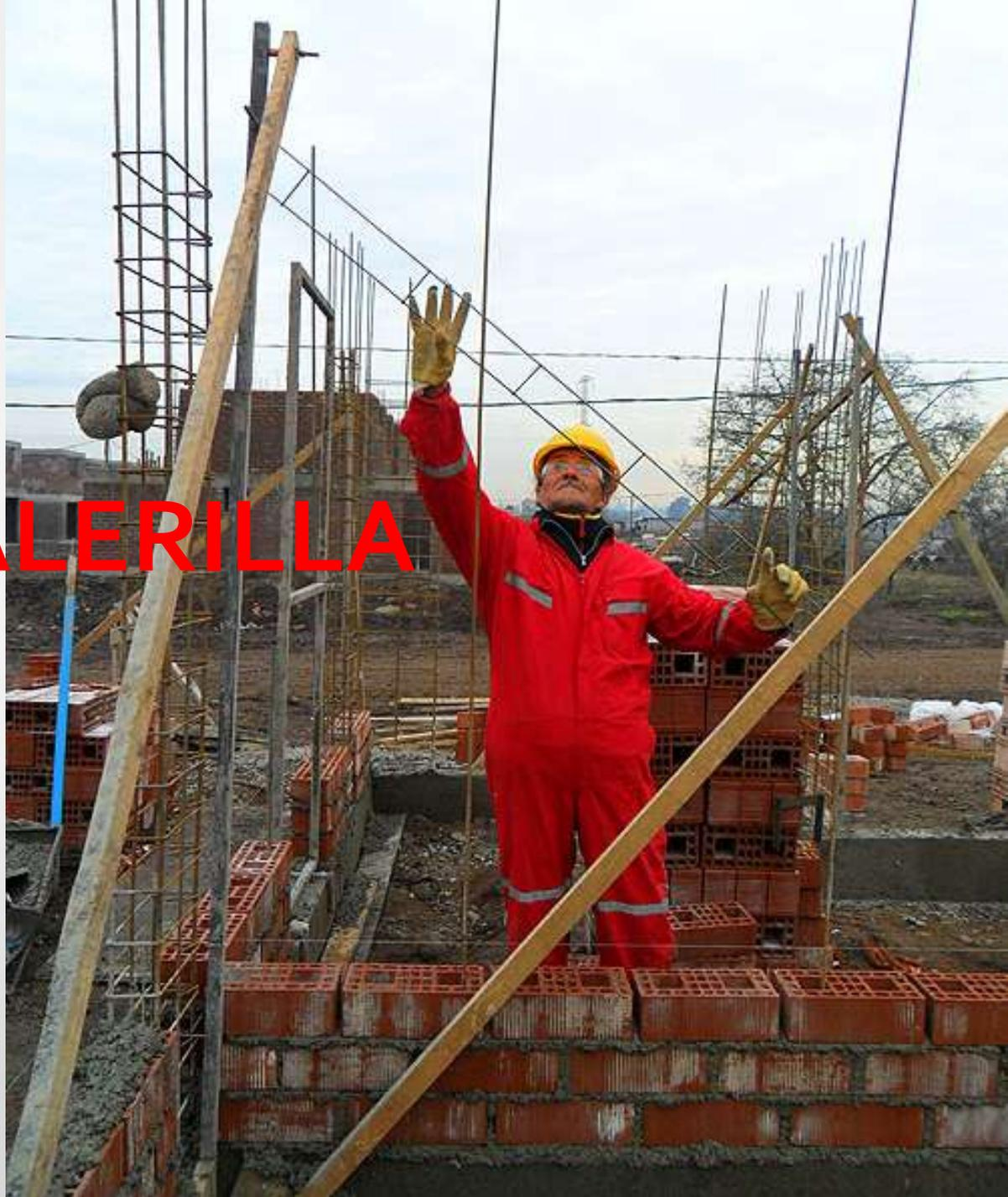
Es un elemento fabricado con acero de grado 60, laminado en frío y electrosoldado. Se utiliza para el refuerzo horizontal de muros de tabique rojo recocido, refractario o block de cemento.
