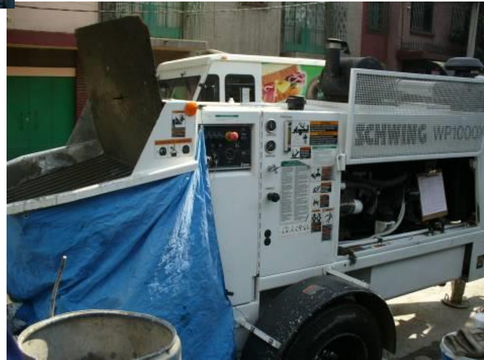
Bomba estacionaria instalada en espera de recibir el concreto
