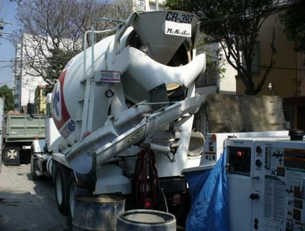
Camión revolvedora llegando a la obra
