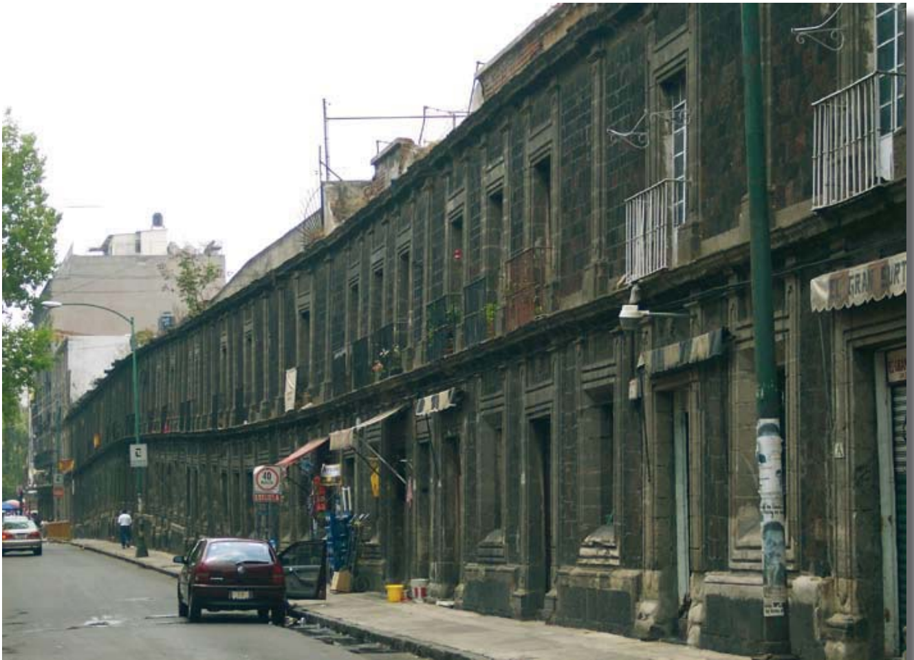
Hundimiento de la Ciudad de México como resultado de la construcción de edificios y estructuras arquitectónicas sobre lecho de suelos paleolacustres.
