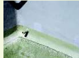
Recubrimiento de depósitos con pintura impermeable resistente a los agentes químicos
