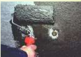
Impermeabilización de puntos húmedos antes de la colocación de cerámica
